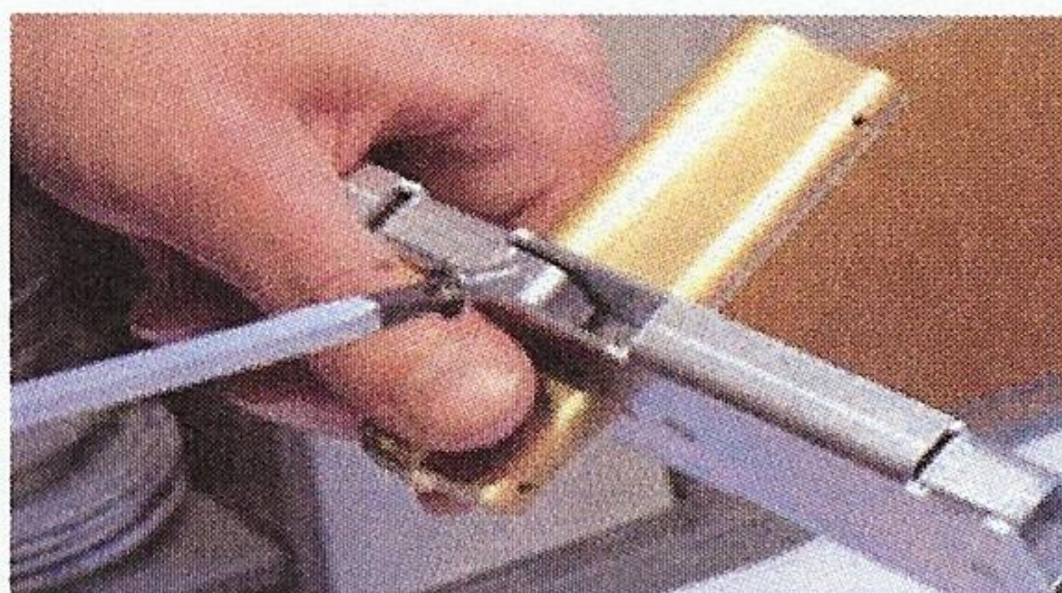
Foto 2: Befestigung des Doppelzylinder im Schlosskasten
