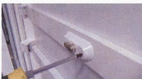
Foto 6: ZPV/Slim mit Innenrosette und Sicherheitsaußenrosette gegenschauben
