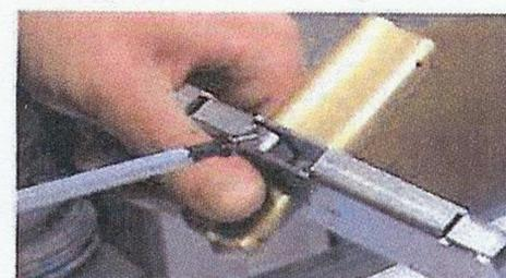
Bild 8: Befestigung des Profilzylinder im Schlosskasten
