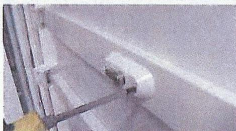
Bild 10: Innenrosette (9) am ZPV/SLIM T30 befestigen
